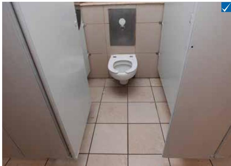
Un buen diseño del baño considera superficies de fácil limpieza por rayados, estanque de agua oculto en la pared y espacios inferiores abiertos para la observación.
